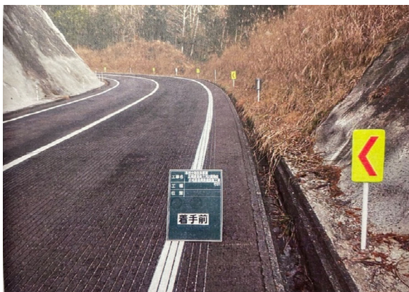
側溝蓋設置工事（西納庫）（着手前）
