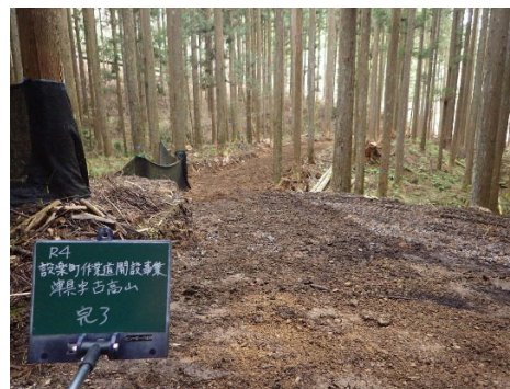
現場写真（作業道開設後：古高山①線）
