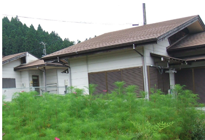
中林住宅E棟修繕工事
