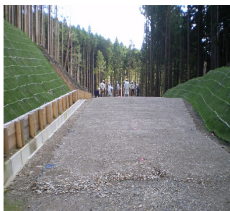
林道中口尤線 3 工区
