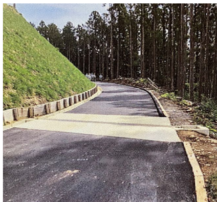
林道中口尤線 1 工区
