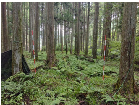
現場写真（作業道開設前：古高山①線）
